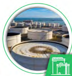
LNG / Tank Terminal
