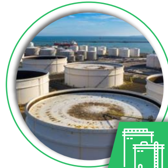
LNG / Tank Terminal
