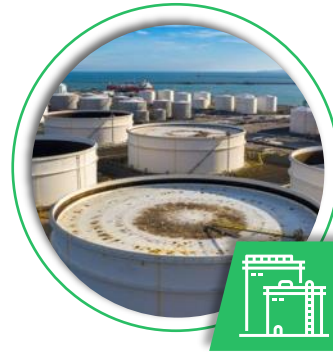
LNG / Tank Terminal
