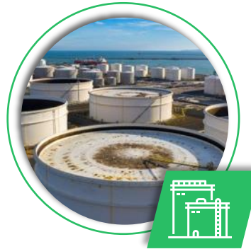
LNG / Tank Terminal
