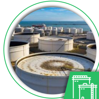
LNG / Tank Terminal
